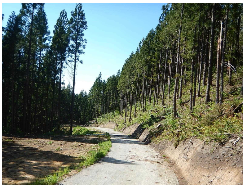
林道の開設（林業専用道）
