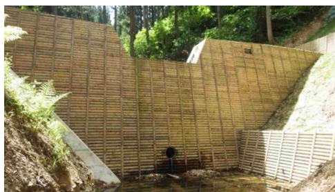
木製残存型杭を使用した治山ダム工
