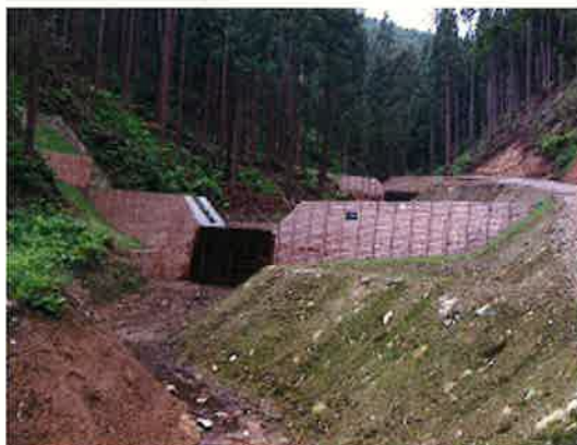
木製残存型桝を使用した治山ダム(小坂町)
