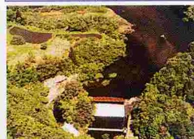
秋田市水道部によって明治44(1911)年竣工し、上水道専用の貯水・取水用ダムとして昭和48年まで使用されました。ダムを備えた近代水道施設として全国的にも古いものです。
