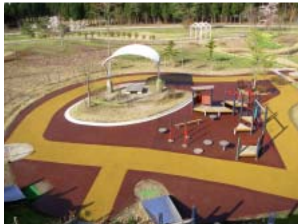
北秋田市・北欧の杜広場舗装 (木質系舗装)
