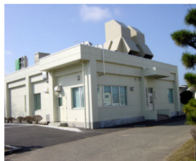
ダイオキシン類分析棟（県健康環境センター）
