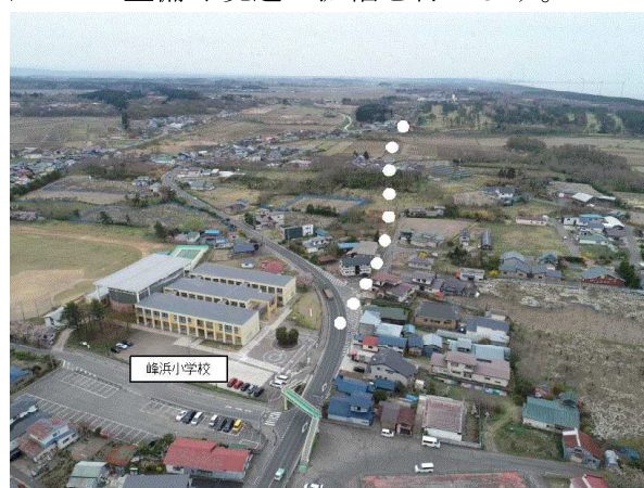
国道101号（峰浜水沢工区）
