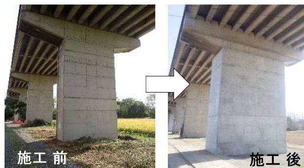
能代高架橋（耐震補強）
