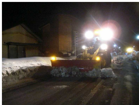
道路除雪（車道）
