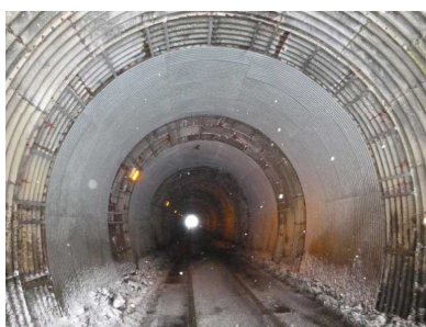
トンネル全体
