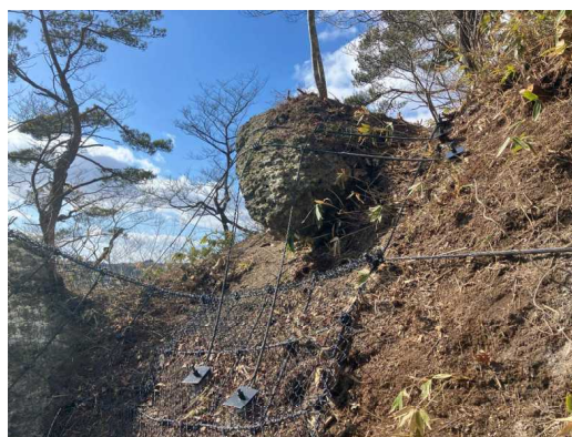
きみまち阪公園素波里湖線 (落石対策状況)
