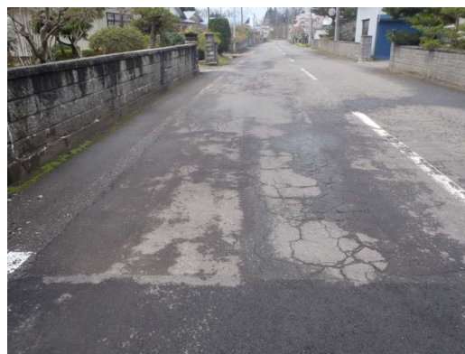
舗装補修予定箇所
