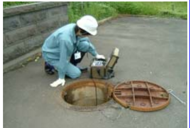
マンホールの点検
