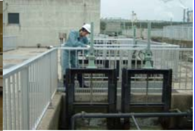
処理施設の点検
