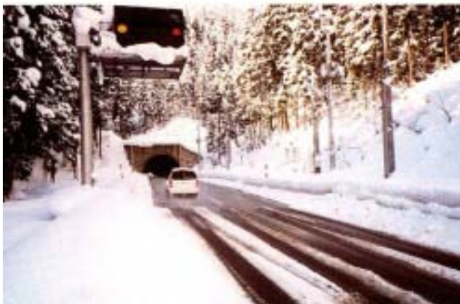
ロードヒーティング(国道285号 大館市)
