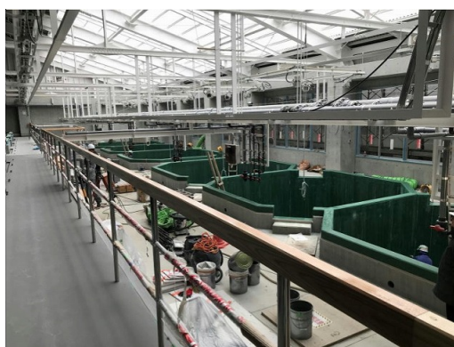
図2 安全な見学に対応した落下防護柵
