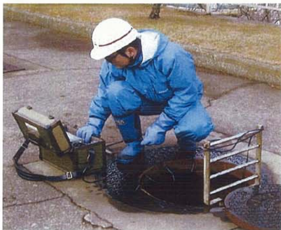
マンホールの点検
