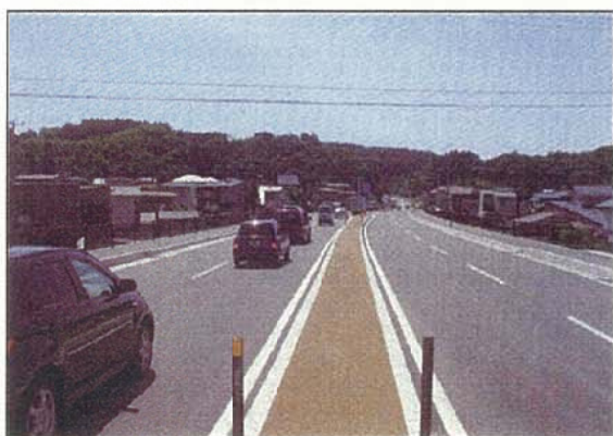
横山金足線 濁川工区（秋田市）
