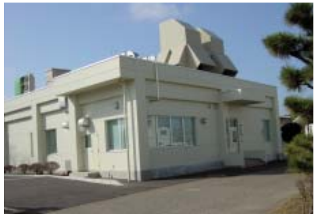
ダイオキシン類分析棟(県環境センター)
