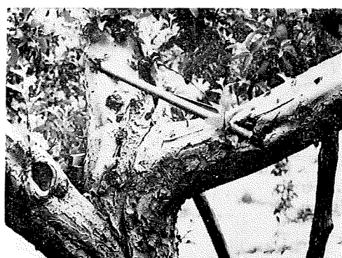
電柱の腕木利用による補修
