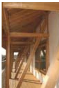
雁木(がんぎ) 長く張り出したひさしが夏の日差しをさえぎり、室内温度は快適に保たれます
