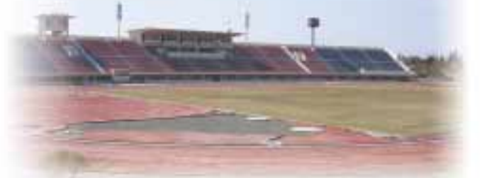
改修工事が進む県営陸上競技場
