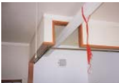
寝室天井部分 既存鉄骨H型鋼があるが、現状では使用されていない
