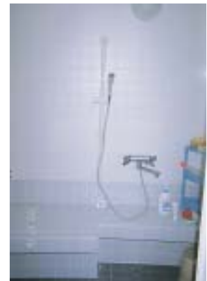
改修後 浴室 移乗台 シャワー
