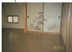
寝室、床ノ間 地板撤去 床、フローア敷
