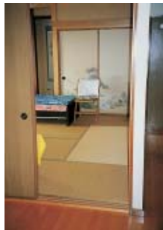
ホール～寝室 敷居の段差と床のタタミ敷きが問題
