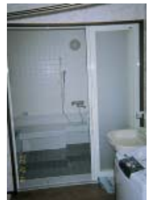
改修後 浴室 洗い場 3枚引戸
