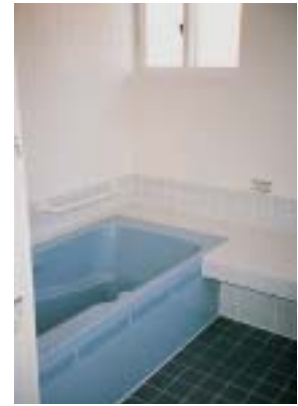
改修後 浴室 移乗台
