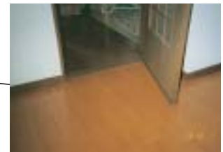
ホール～リビング 出入口扉、敷居取替、扉下端かさ上げ
