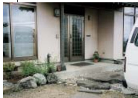
玄関～アプローチ ポーチの段差と飛石が問題
