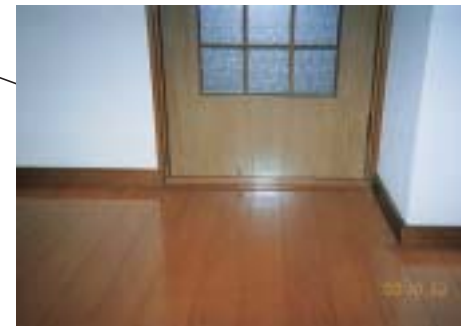
出入口扉 敷居段差
