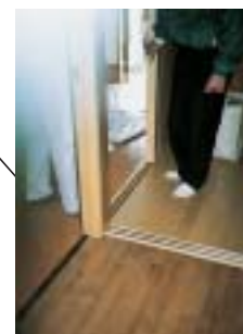
寝室～洗面 脱衣所～ホール 敷居取替
