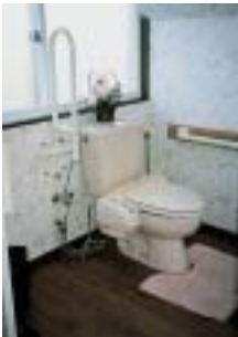
便器、手すり取付
