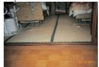
寝室・廊下 敷居段差解消スロープ
