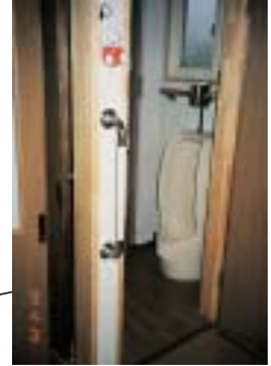
トイレ 片開扉 床段差解消 手すり取付
