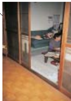
居間・廊下 敷居段差解消 スロープ
