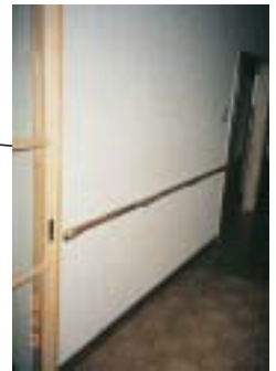
ローカ 手すり取付
