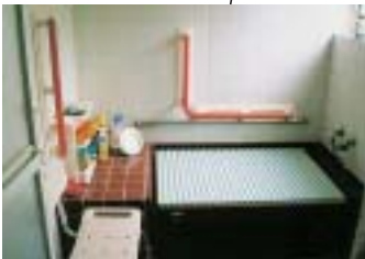
新たに手すり取付け
