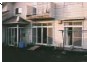
屋外スロープ
