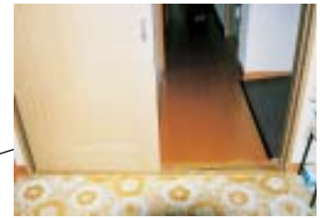
寝室～ローカ 出入口、扉を引き戸に取替、段差解消
