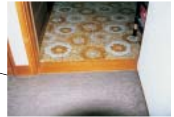
居間～ローカ 片開扉用敷居取替、段差解消
