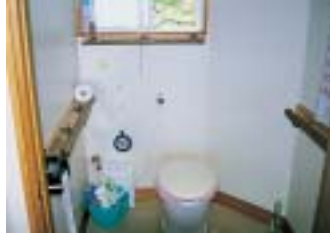
入口から車イスで入れるようになったので手すりを安定して使える位置に取付け、自分で排泄できるようになった
