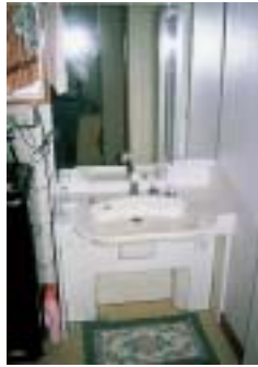
洗面台 昇降機能付き洗面台に取替
