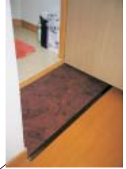
トイレ前スロープ 一度モンタリングをした後での完成品
