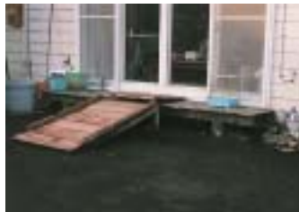
テラス出入口 息子がつくってくれた木造スロープ
