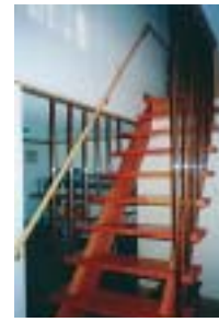
1～2階の階段手すり
