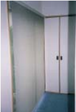
1階縁側 今回増築と考えていたスペース
