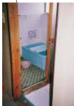
既存浴室 シャワーなし
