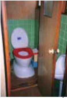
既存トイレ 大便器
