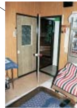
改修前 居間 キッチン・居間に入る狭 いところにドアが3ヶ所も あり、左半身不随でのつえ 歩行の移動は大変。
