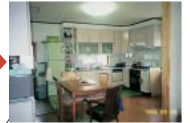
改修後 キッチン・食堂 キッチンと居間の間仕切を取除き、東 側に1間伸ばしてテーブルでゆっくり食 事をとれるようにした。 流し台は、妻の夢だったメーカーのシ ステムキッチンを採用。吊戸棚が低くな った上、毎日の食器は、ここに全て収納さ れたので動きがかなり楽になった。
