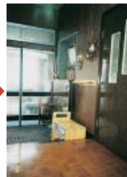
改修後 玄関 靴の着脱が楽にできるよ う腰掛けを製作。 壁に手すりを取付。
