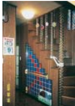
改修後 廊下 つえと同じ高さに手すり を取付。天井に照明を取付 て足元を明るくした。
