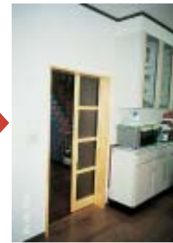
改修後 食堂・居間 キッチン・居間をワンル ームにし、ドアを車イスでも 通行可能な幅970cmの引戸 にした。
