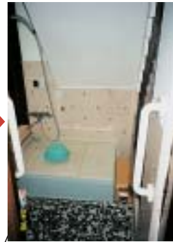
改修後 浴室 浴槽の奥の壁にし型手す りを取付。浴槽の脇に腰掛 け台を設置。 シャワー水栓をサーモ スタット付シングルレバー水 栓に取替えた。
