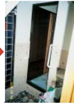
改修後 浴室 出入口の両サイドに手す りを取付。
