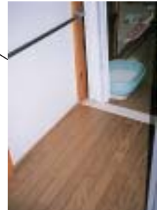
ローカ敷居 段差解消
