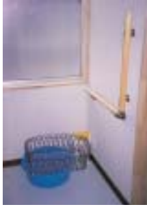
改修後 脱衣室手すり取付
