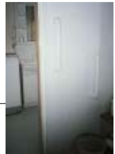
改修後 浴室出入口手すり
