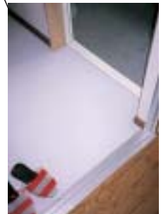
改修後 洗面・脱衣室
