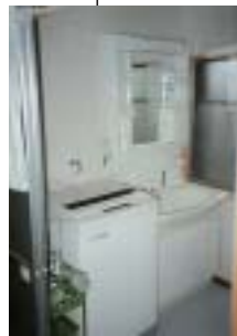
改修後 洗面・脱衣室
