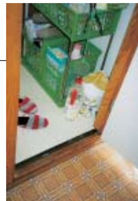
浴室脇物置 以前はトイレであった
