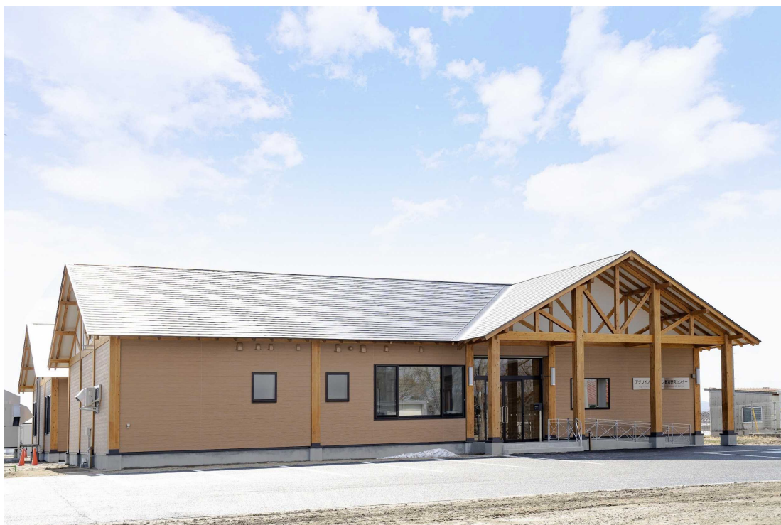
研究・管理棟（R5年2月15日完成）
