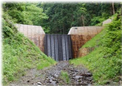
木製残置型枠
