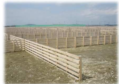
海岸林造成工事（静砂垣）
