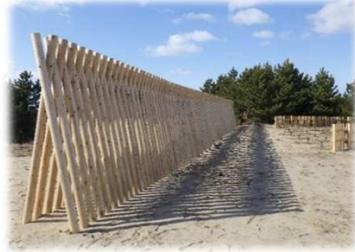
海岸林造成工事（防風柵）
