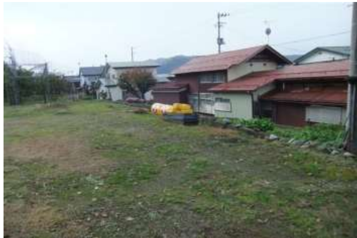
写真ア：中央に工事用資材がある。
