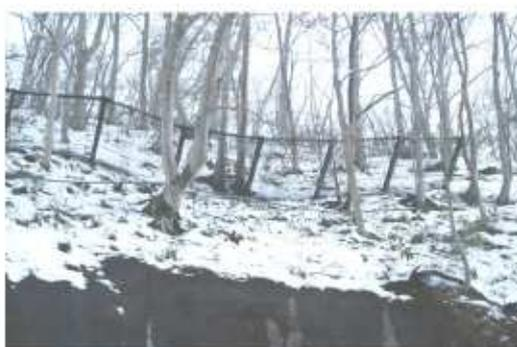
吊式落石防護柵 設置箇所
