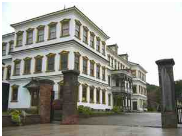
小坂鉱山事務所
