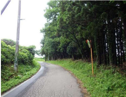
にかほ市 整備後
