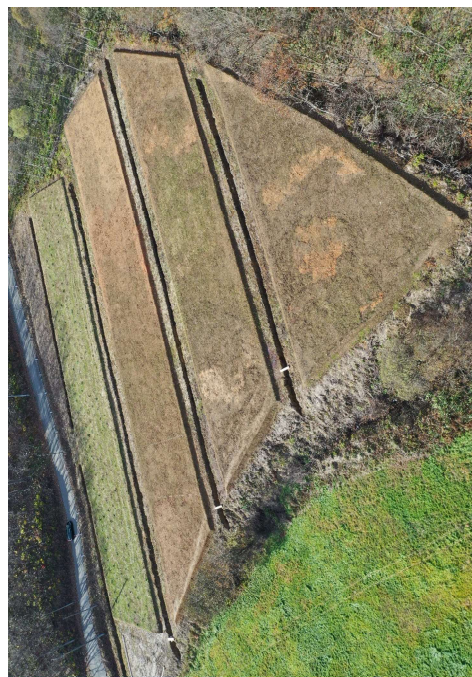
湯沢市 整備後 (ドローン撮影)
