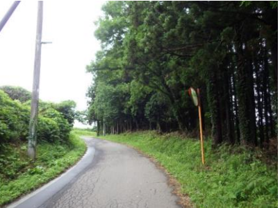
にかほ市 整備後
