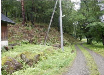
湯沢市 整備後
