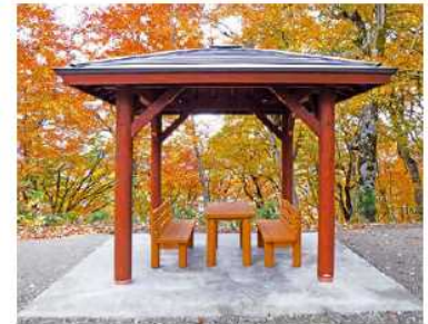
休憩施設整備(湯沢市)
