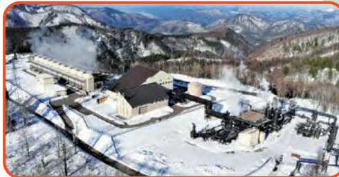
山葵沢地熱発電所(写真提供:湯沢地熱株式会社)
