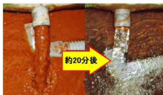
地下かんがいによる暗渠内の洗浄
