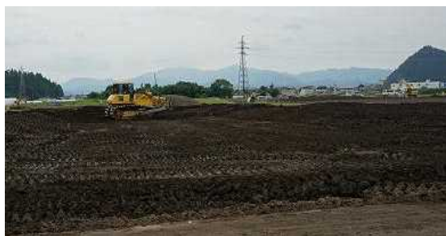
（大館市上川沿地区のほ場整備事業）
