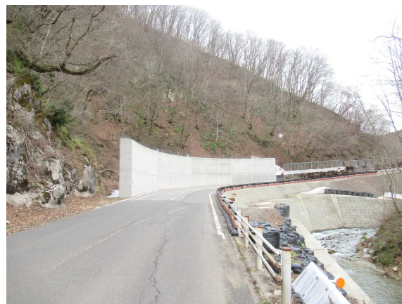
（令和4年度 スノーシェッド 山側下部工）
