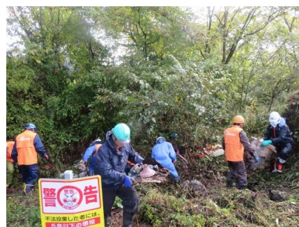
(不法投棄廃棄物撤去作業)
