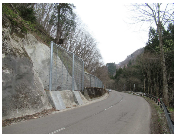
（国道105号 令和4年度 落石防護柵工）
