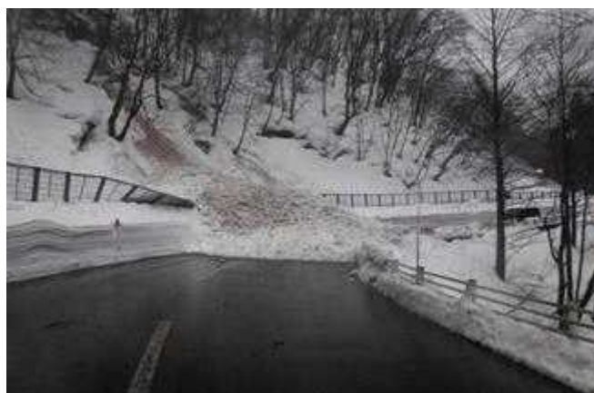
（H29. 2. 17雪崩発生状況）
