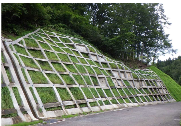
（県道比内森吉線 令和4年度 法枠工）
