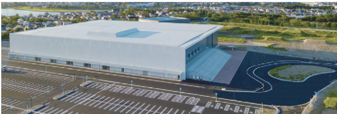
国道7号線沿いに位置し、約千台分の駐車スペースを確保
