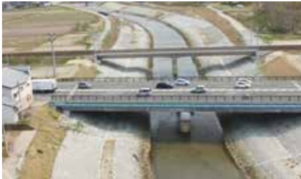
河川改修状況(新城川・秋田市)
