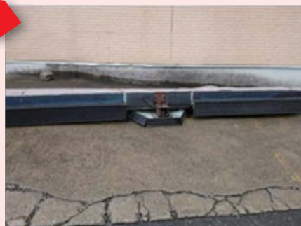
落下した欄間看板
