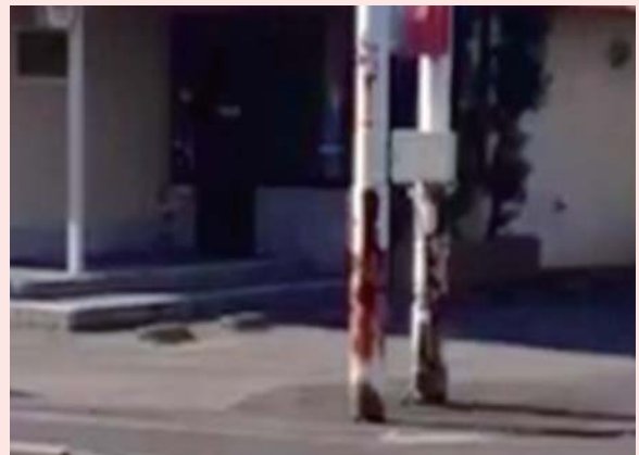
ポールの根腐れ（実際に倒れた看板）
