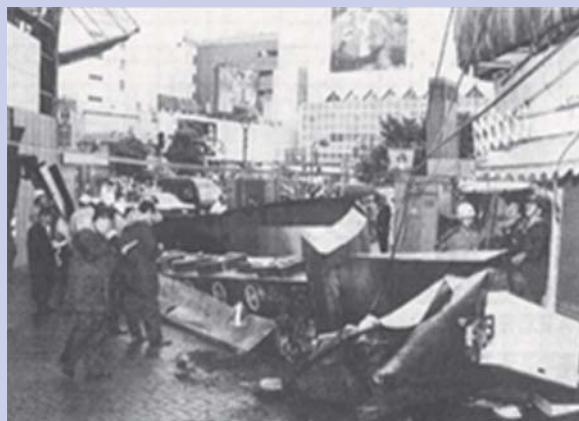
台風で落下した時の様子
