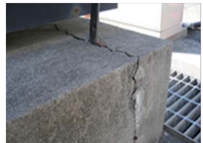
看板基礎のひび割れ
