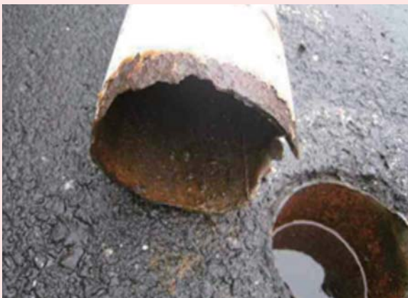
ポールの根腐れによる倒壊
