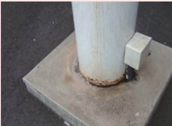
ポールの根元にサビが発生
