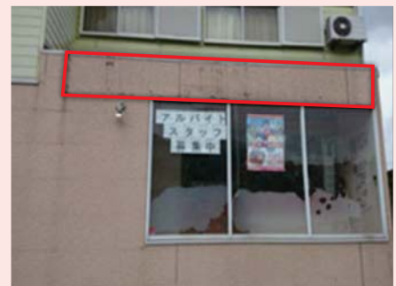
落下した後の壁面
