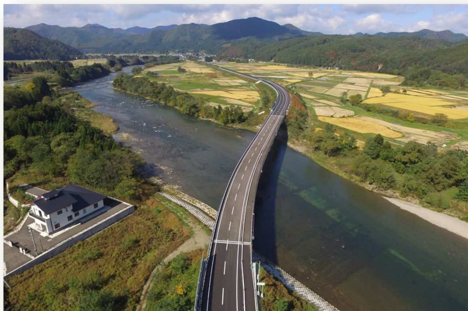
国道103号 葛原BP (H28.10開通)
