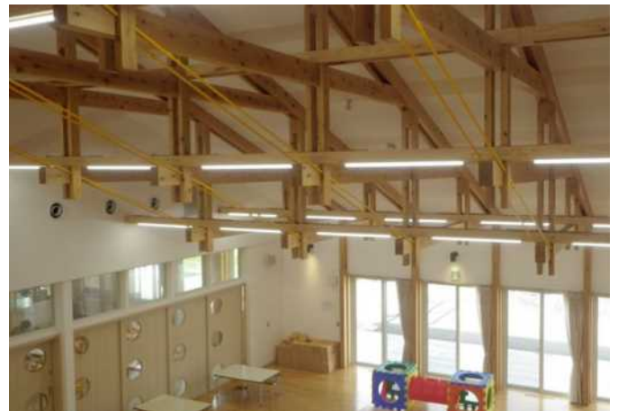
既存の製材品を巧みに組み合わせた屋根組 持つ子ども園「峰浜ポンポコ子ども園」
