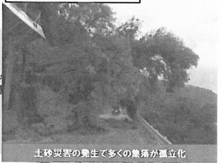
土砂崩落(H23.8月・H29.6月発生)
