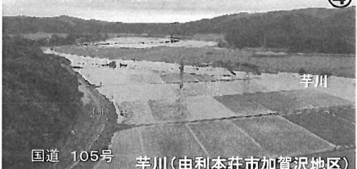
H29.7月洪水浸水状況
