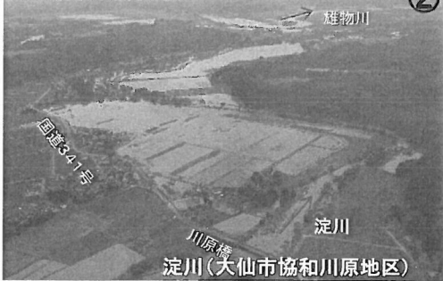
H29.7月洪水浸水状況
