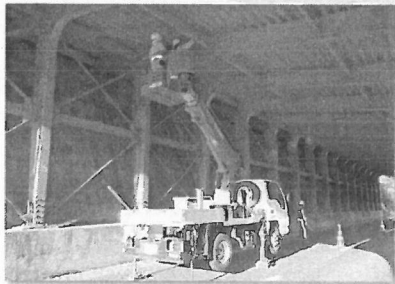
道路施設点検
