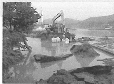
災害復旧作業
