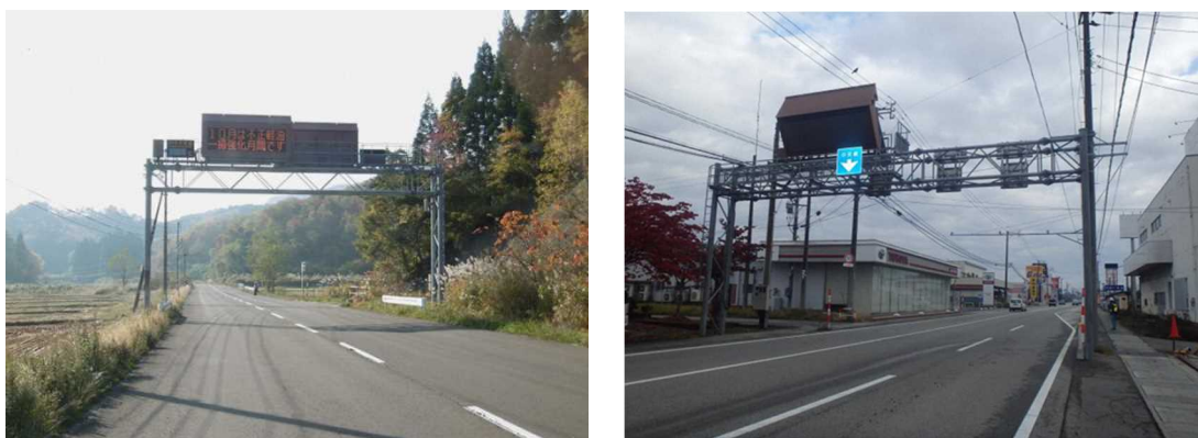
写真-2 門型道路情報提供装置の例
