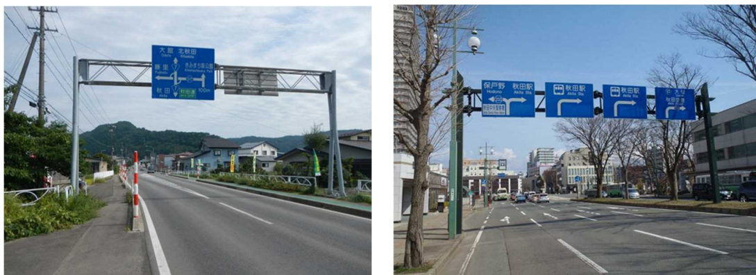
写真-1 門型道路標識の例
