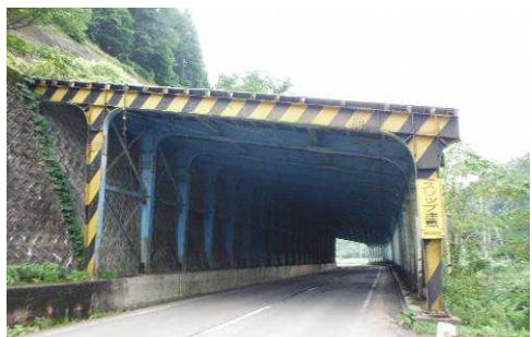
写-2.2.3 スノーシェッドの例
