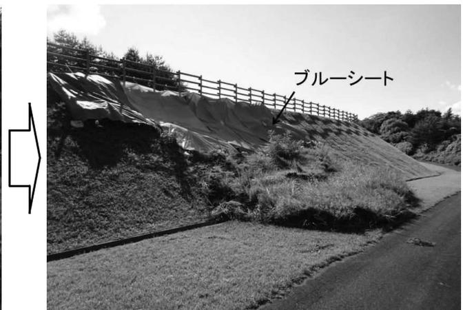
写真6 ブルーシートによる応急処置
