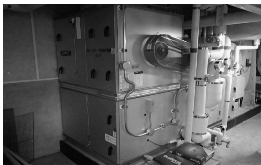
⑥健康環境センターバイオハザード室改修（空調機器更新）
