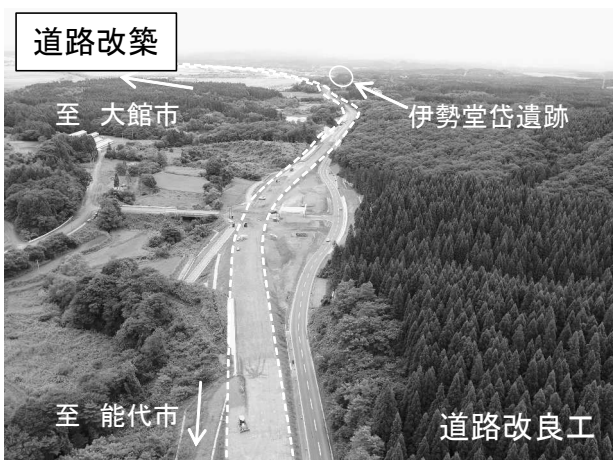
大館能代空港西線 鷹巣西道路工区 (北秋田市)
