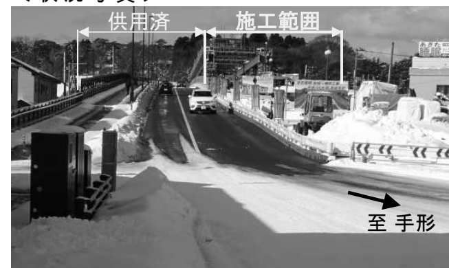
供用区間(秋田駅側)の融雪施設稼働状況
