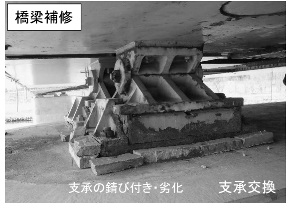
おおあげ 横手大森大内線 大上橋工区 (横手市)
