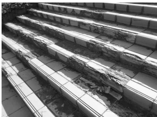
階段補修 [小泉瀉公園]
