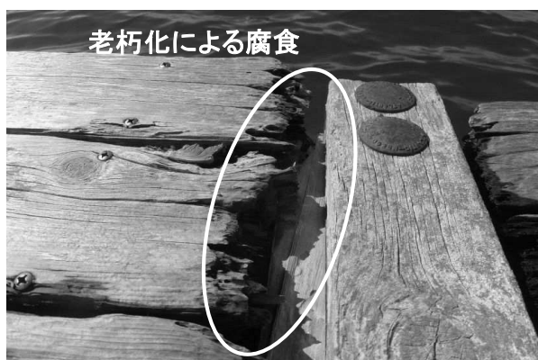
栈橋改修 (秋田マリーナ (近景))
