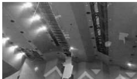
ホール (変形天井)：天井脱落、下地変形
