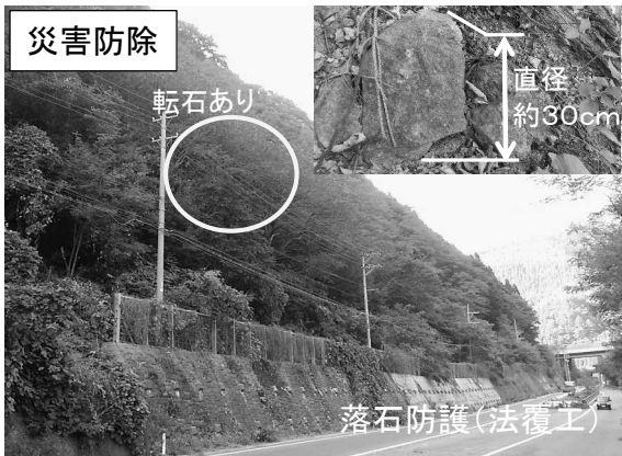
あずきざわいかり 国道282号 小豆沢碓工区 (鹿角市)
