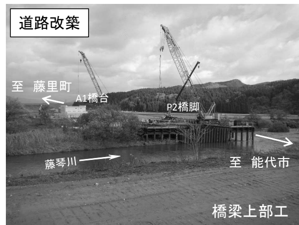
西目屋二ツ井線 にあげば 荷上場工区 (能代市、藤里町)
