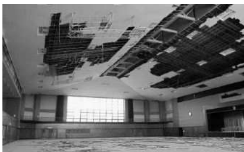
体育館：天井脱落、下地破損
