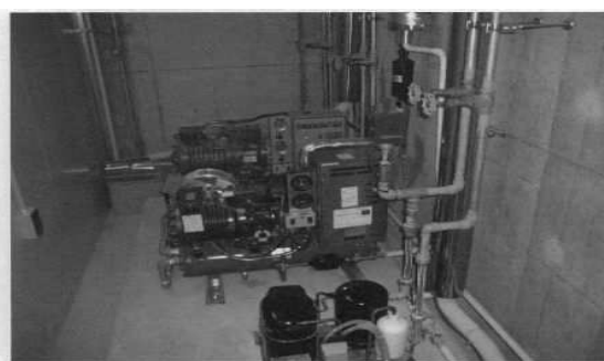
⑧総合食品研究センター 恒温恒湿用冷凍機更新
