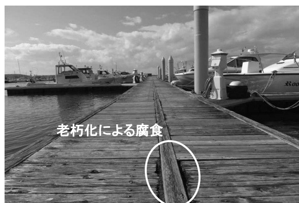
栈橋改修 (秋田マリーナ (全景))
