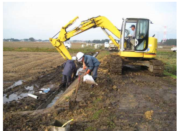
農業用水路の更新
