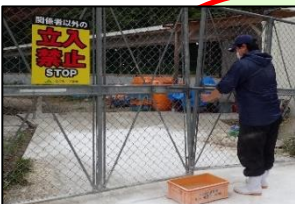
フェンス設置
