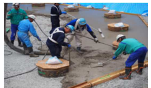
開発したリミックスコンによる工事
